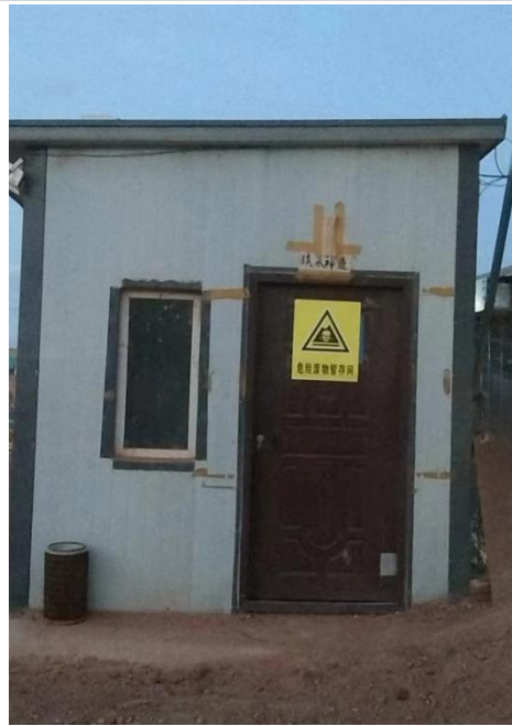
危险废物暂存间
