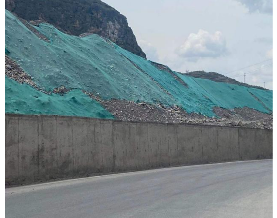
堆场苫盖及围挡
